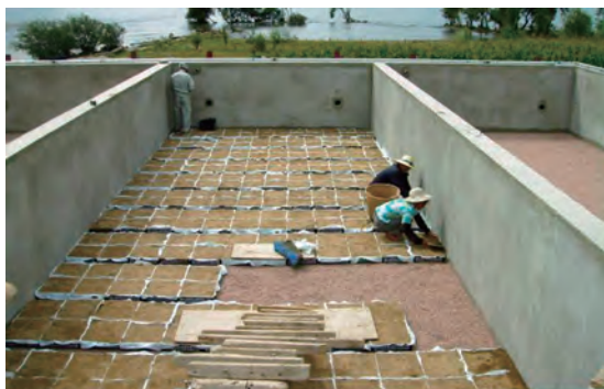
写真5 土壌処理用土壌ブロックを敷き詰める
