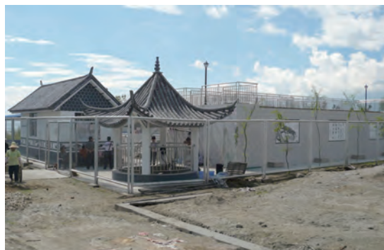
写真7 白族の建築様式を取り入れた処理施設の外観
