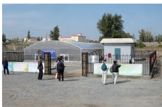
写真4 処理施設の外観
