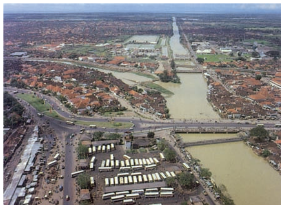
写真4 インドネシア国スラバヤ河放水路(右)とマス河(旧スラバヤ河)
