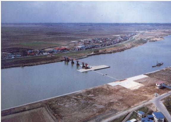
写真6 芦野堰(青森県岩木川)
