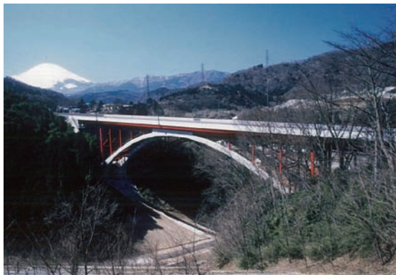
写真1 制振・耐疲労性向上対策の実施事例 (アーチ橋のコンクリート巻立て)
