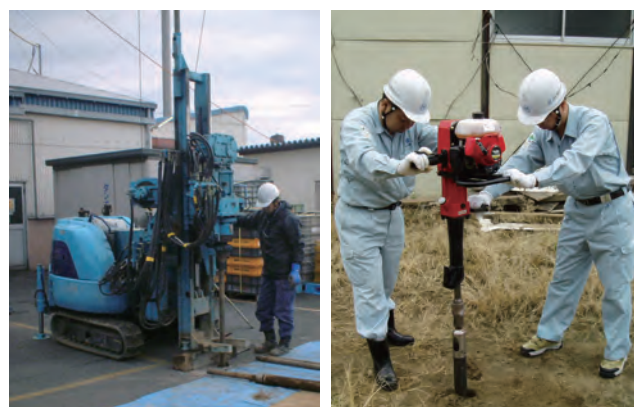
ボーリング調査
