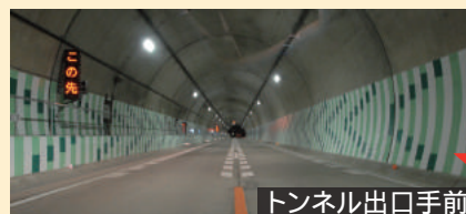
実際の施工済みトンネル内写真→
