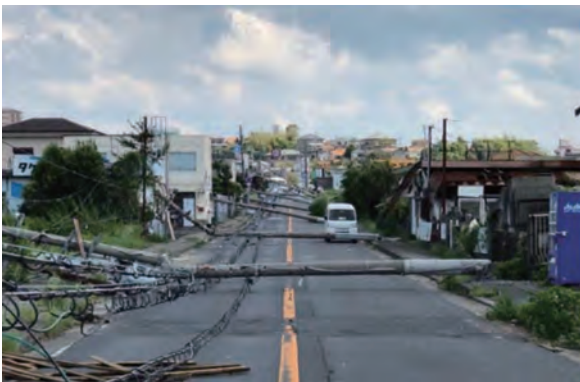
写真1 2018年9月台風21号による電柱倒壊の被害状況 (大阪府泉南市) 2)
