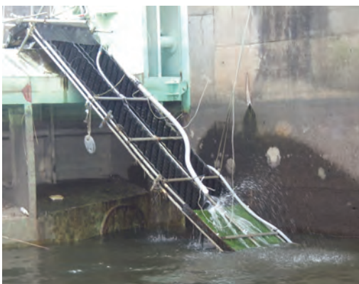
写真3 イールラダー設置状況
