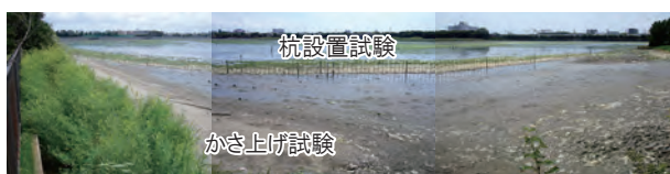
写真6 かさ上げ・杭設置試験
