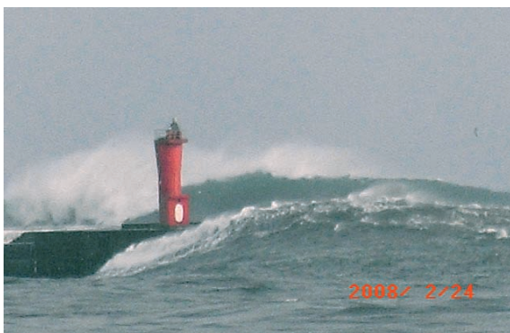
写真1 寄り回り波の様子(伏木地区北防波堤東端)
