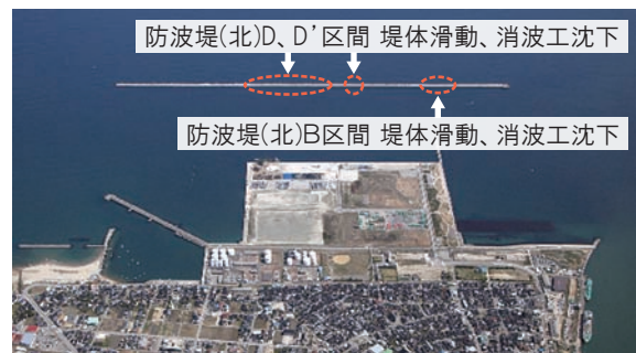
写真2 防波堤の被災区間(伏木地区北防波堤)
