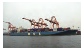
写真7 ガントリークレーン
