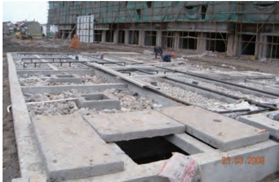
写真1 ろ材である礫の充填状況
