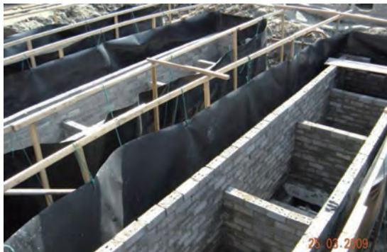
写真3 防水膜とブロック壁で躯体を構築
