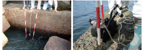
写真2 水中カメラによる鋼矢板腐食状況調査
