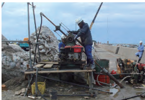
写真5 基礎付近までの調査孔の設置作業状況
