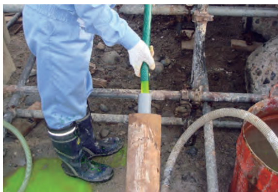
写真6 着色水の注入状況
