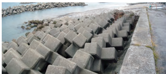
写真4 試験箇所の状況
