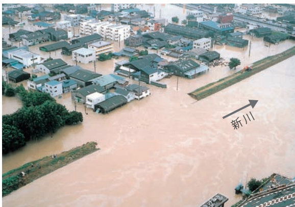
写真1 東海豪雨による新川(愛知県)の破堤状況(2000年)
