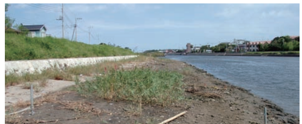
写真2 工事後1年目の現地の状況
