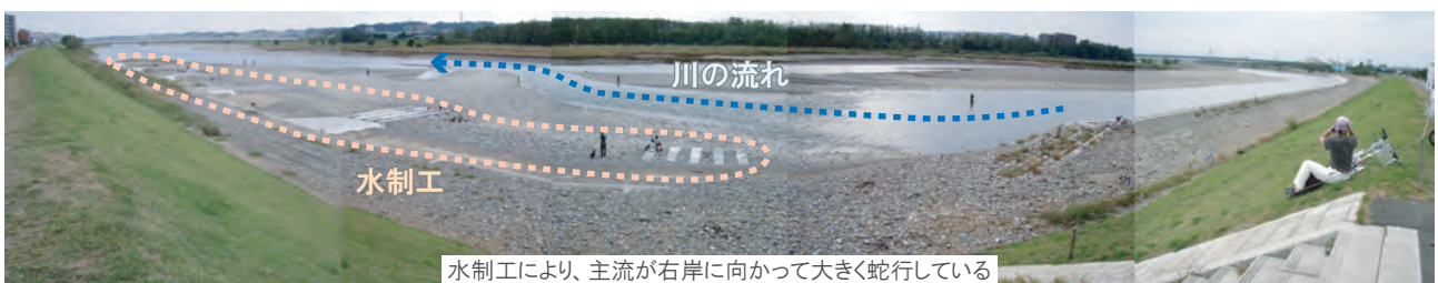
図4 多摩川左岸・上石原付近の水制工
