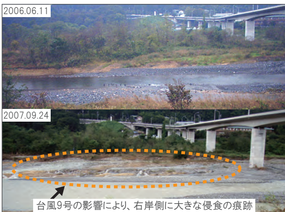
図3 多摩川羽村大橋下流右岸の状況
