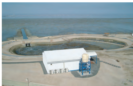
写真2 建設された実験干潟
