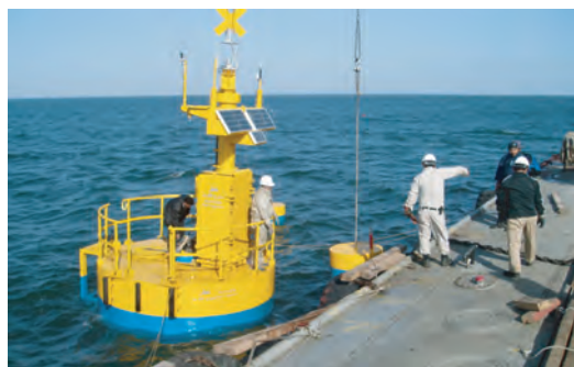
写真3 モニタリングブイの設置
