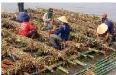
写真1 パイロット護岸工事での栗石柳枝工の適用
