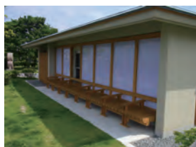
写真5 操作室の穴道湖側
