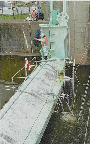
八間堰水門に取り付けられた魚道（右）のアップ。魚道には、ウナギの産卵を確認するための、すいすい網が取り付けられている。
