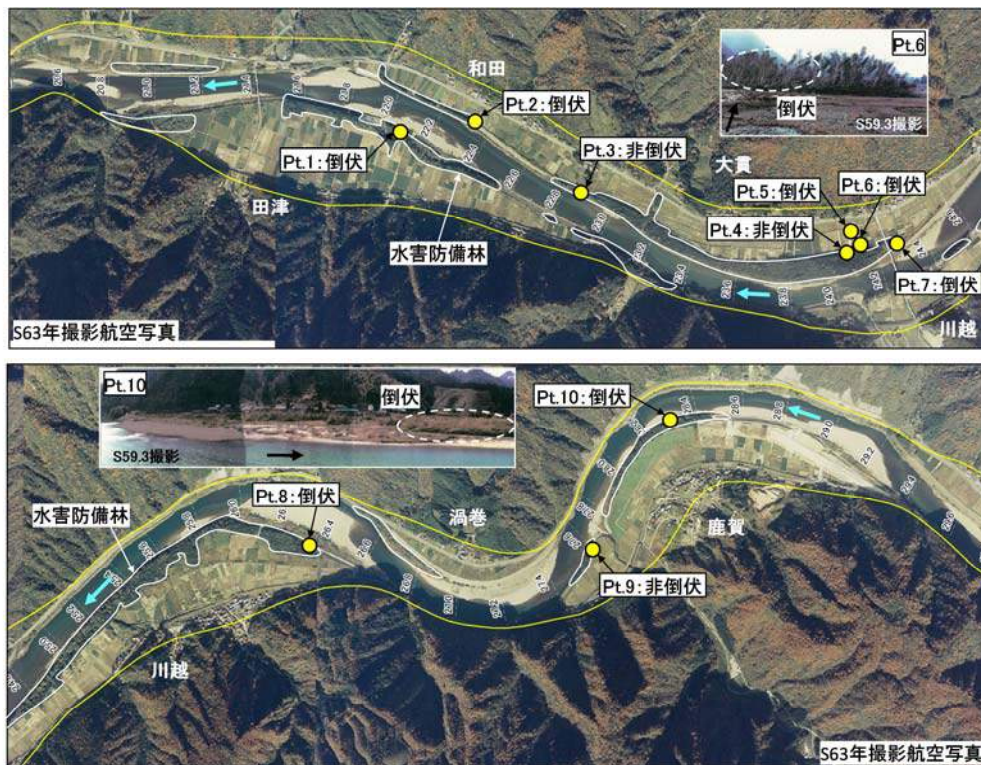
図-1 S58.7洪水後の航空写真及び洪水後の水害防備林状況
