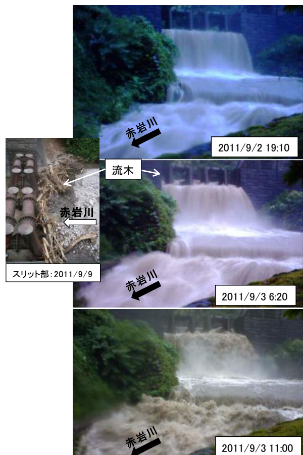
図-6 福原2号砂防堰堤の流況画像
