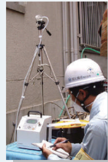
大気中の石綿濃度測定
