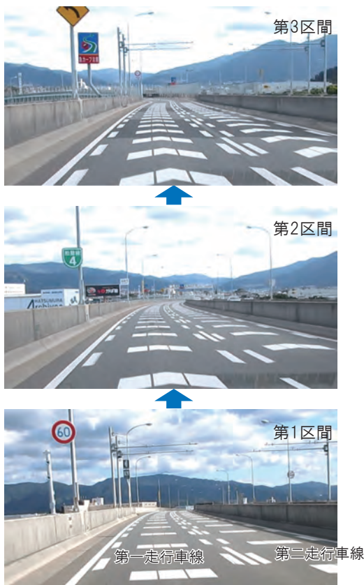
図2 シーケンスパターンの施工事例(福岡高速4号線)
