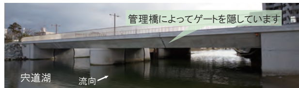
写真3 宍道湖側から見た天神川水門
