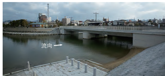
写真8 穴道湖側から天神川水門を望む
