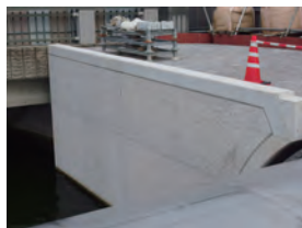
写真4 表面のはつり仕上げ
