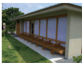
写真5 操作室の穴道湖側
