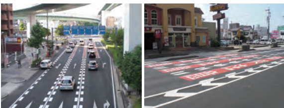
写真1 減速ドットラインやカラー舗装の事例(愛知県)
