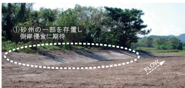
図4 砂州掘削直後の状況(2007.9撮影)
