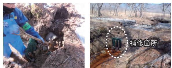
写真4 遮水堰周辺の補修状況(2010年12月)
