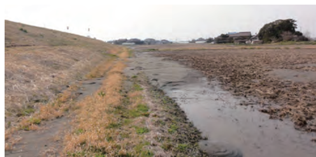
写真6 堤防周辺の液状化状況
