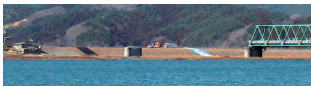
写真1 2連の橋桁が流失した新北上大橋
