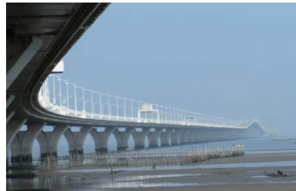
写真2 免震支承を用いた10径間連続橋梁 (東京湾横断道路 木更津側橋梁)
