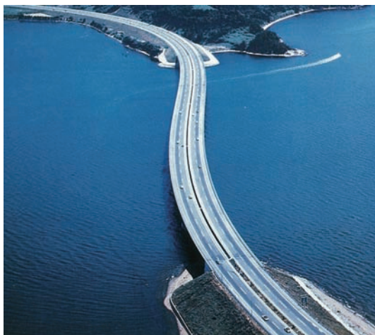
写真1 S字形平面の曲線橋(浜名湖橋;静岡県浜松市) (1968(昭和43)年度土木学会田中賞を受賞)
