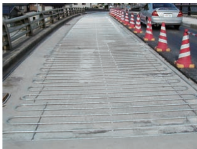
写真1 路面の放熱管配管状況
