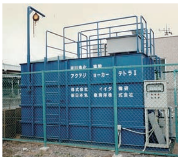
写真1 水質浄化装置(アクアジョーカー)
