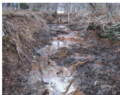
写真5 排水路の浸食
