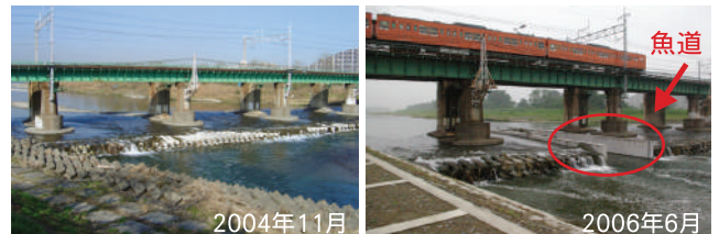
写真1 中央線護床工対策の前後の状況
