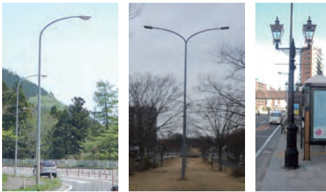
写真1 道路照明施設の例
