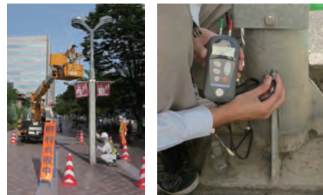
写真2 定期点検状況
