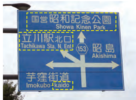
図3 改修前の方面および方向標識 (例1:英語併記・ピクトグラム(絵)標示がない)
