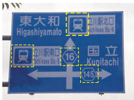
図6 改修後の方面および方向標識 (例2:ピクトグラム・路線番号標示)
