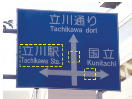
図4 改修前の方面および方向標識 (例2:ピクトグラム・路線番号標示がない)
