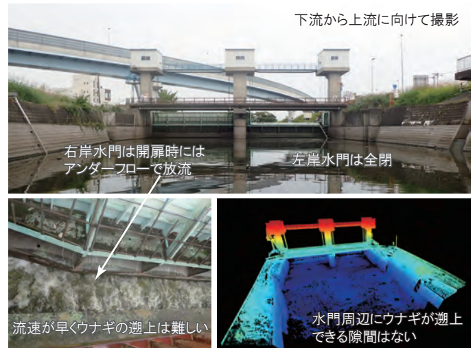
写真1 八間堰水門の状況
