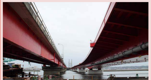
完成写真(左:旧橋、右:新橋)
