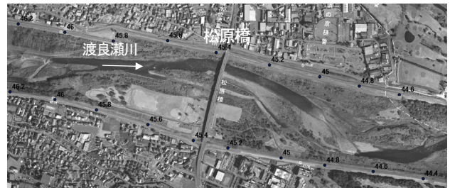
写真-1 平成23年9月出水前の空中写真（松原橋付近）
