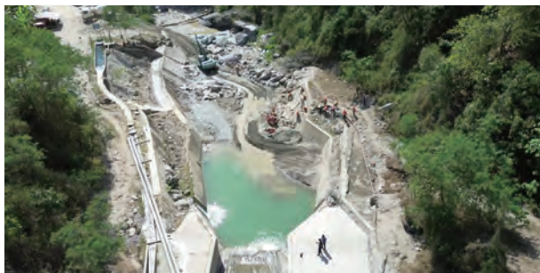
上水道用取水堰下流の護岸復旧工事の様子
