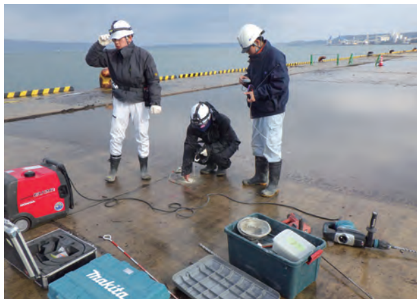
七尾港 岸壁の地中空洞調査の実施 写真提供元：国土交通省北陸地方整備局
