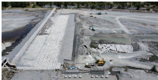
農業用取水堰の護岸・護床工復旧工事の様子
