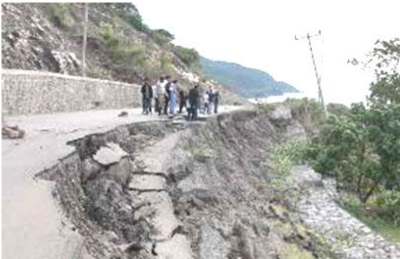
大雨の影響による大規模な道路の崩壊
