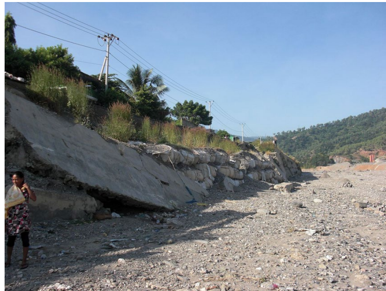
首都ディリを流れるコモロ川護岸の損傷状況
