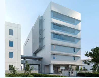
応用生命科学研究センター（建設中）
