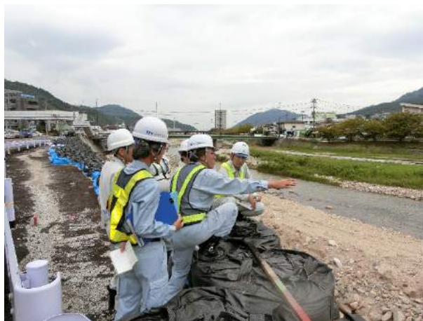
国道2号兼用護岸の被災 「発注者との現地合同会議」
