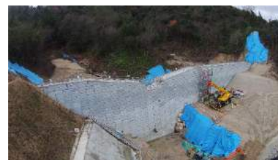
当社設計の砂防堰堤の施工状況
