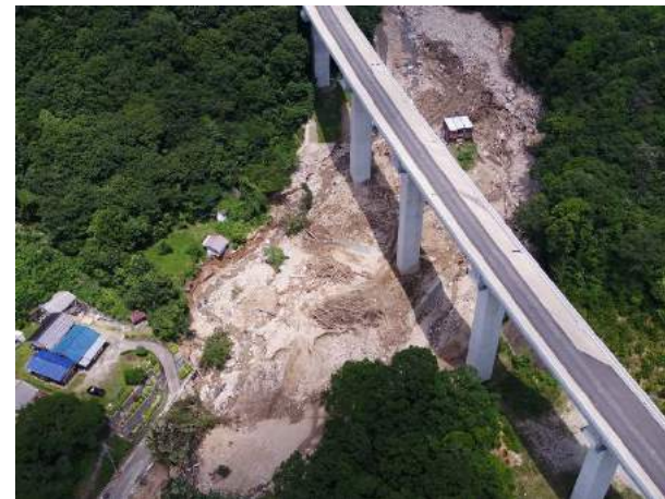
広島県安佐北区の土砂災害 「ドローンによる撮影」
