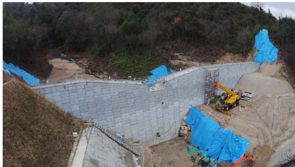
【当社設計の砂防堰堤の施工状況】
